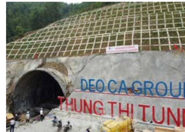
Hầm chui Thung Thi - Tam Điệp Thung Thi Tam Diep tunnel
