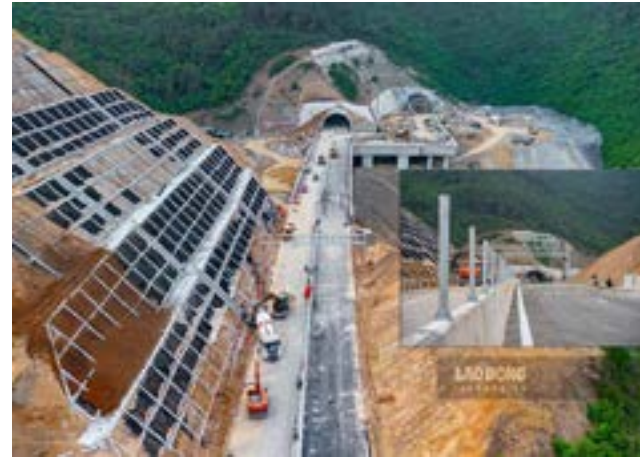
Hầm Thần Vũ Than Vu tunnel
