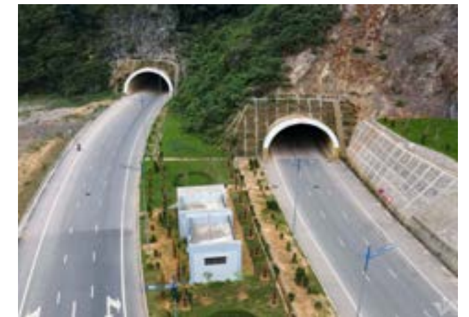
Hầm xuyên núi bao biển Hạ Long - Quảng Ninh Tunnel through the mountains and sea in Ha Long - Quang Ninh
