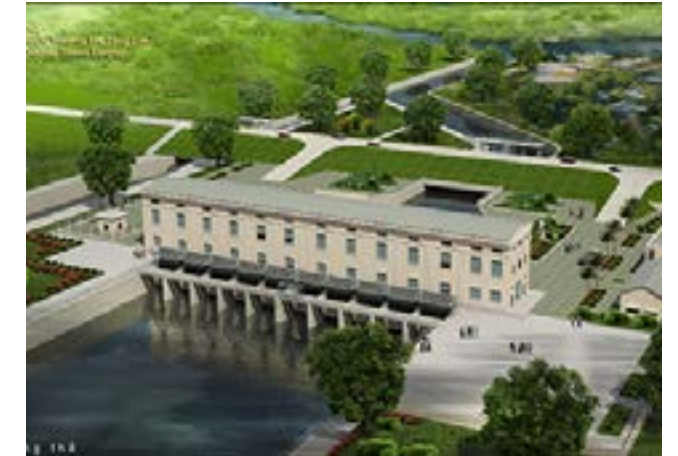
Trạm bơm Sai Nga - Phú Thọ Sai Nga pumping station - Phu Tho
