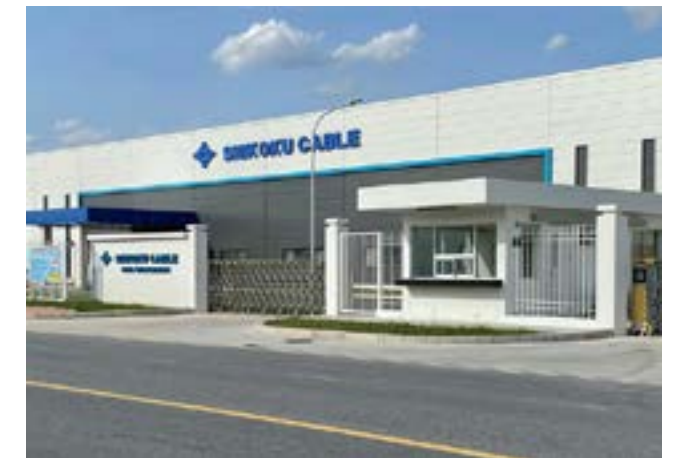
Trạm xử lý nước thải Nhà máy Shikoku Việt Nam Shikoku Vietnam Factory Wastewater Treatment Station
