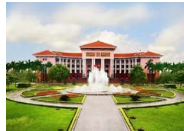
Hệ thống tưới tiêu tự động - Trụ sở Bộ Quốc Phòng Việt Nam Automatic irrigation system - Vietnam Ministry of National Defense Headquarters
