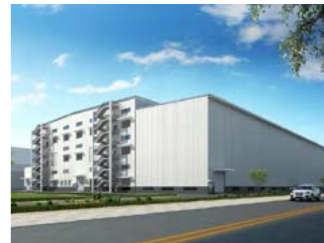
Nhà máy Naise new Materials Việt Nam Naise new Materials Vietnam Factory
